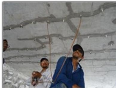
Inyección de grietas con resinas epóxicas.
