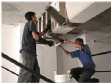
Instalación de fibras de carbono en platina y malla.
