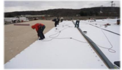
Instalación de sistemas de impermeabilización: Acrílicos, Mantos Asfálticos, Poliuretano, Híbridos, Membranas de PVC y TPO
