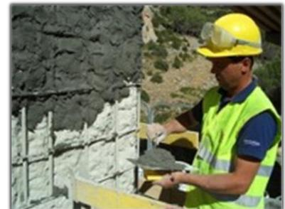
Saneamiento y recuperación de secciones en concretos dañados.
